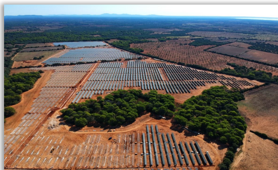
Impianto fotovoltaico Isole Baleari – Sa Caseta
