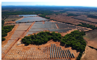
Impianto fotovoltaico Isole Baleari – Sa Caseta (2020)
